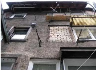
Das Gebäude Friedrichstraße 2 ist ein dreigeschossiges Geschäfts- und Wohngebäude, das um ca. 1758 errichtet wurde. Das Gebäude wies vor den Sanierungsmaßnahmen Defizite auf, die behoben wurden. An der Dachunterseite wurde eine Wärmedämmung angebracht sowie die Fenster durch isolierverglaste ersetzt.
