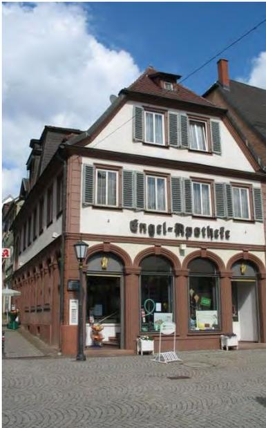
Nach dem Umbau der Apotheke im Jahr 2000 wurde es notwendig weitere Außenbauteile, zu erneuern. Dabei wurden Wärmedämmungen an den Außenwänden sowie zur obersten Nutzungseinheit eingebaut. Zudem konnte durch das Austauschen der Fenster eine deutliche Verbesserung der Wohnverhältnisse erreicht werden. Im Rahmen der Außensanierung des denkmalgeschützten Gebäudes wurden die Dacheindeckung und -konstruktion komplett erneuert, ebenso die Dachfenster, die Dachentwässerung und die Dachaufbauten.
