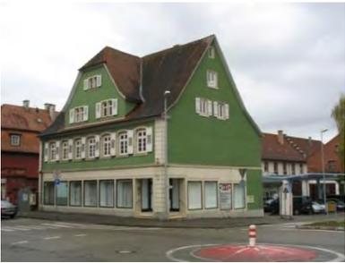
Das Gebäude befindet sich am westlichen Ende des Sanierungsgebiets. In den vergangenen Jahren wurden nur wenige Modernisierungsmaßnahmen durchgeführt. Die Sanierung beinhaltet vornehmlich das Aufwerten der Erdgeschossebene und in diesem Zuge das Erneuern und Neugestalten der Schaufenster sowie der Eingangstür. Aber auch die Räumlichkeiten in den oberen Geschossen wurden einer Erneuerung unterzogen. Des Weiteren musste die vorhandene Öl-Zentralheizungsanlage altersbedingt ersetzt werden.
