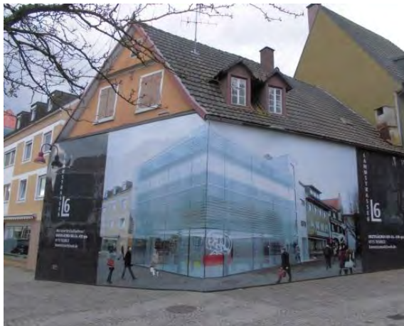
Foto 7: bauliche Veränderungen - Lammstraße
