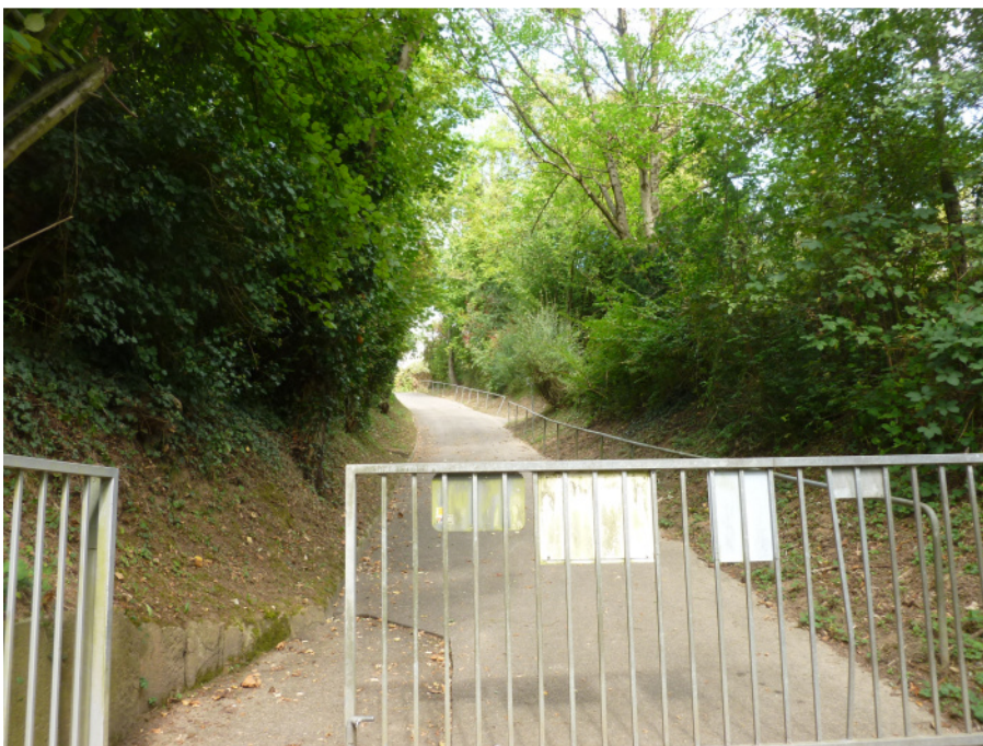
Standort 2 (Zufahrt Nord) Höhenunterschied: 90 cm Steigung: 22,5 %
