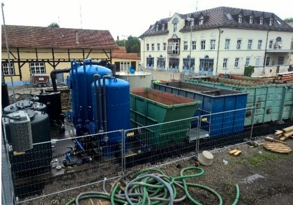
Foto 5: Bauwasserreinigungsanlage
