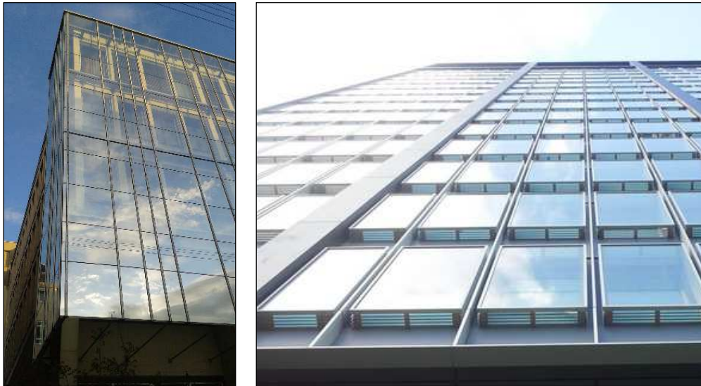
Abbildung 2 – Beispiele für vorgehängte Fassaden 1 (links) und Prallscheiben 2 (rechts)
