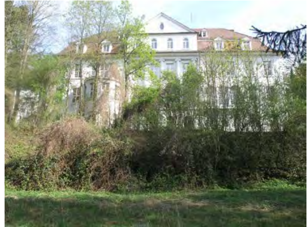
Bild 5: Thaeder-Haus; zum Erhalt vorgeschlagen werden nur einzelne Bäume / Gehölzgruppen seitlich des Gebäudes, um die Fassade freizustellen.
