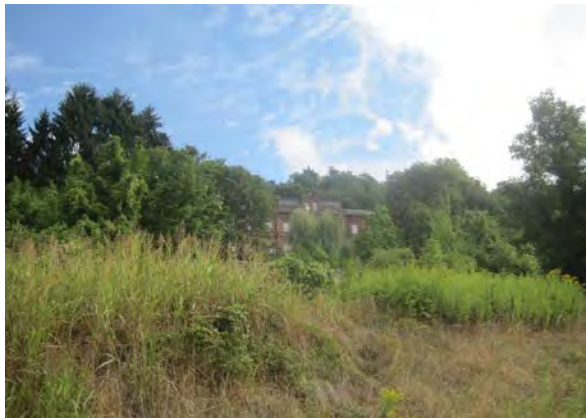
Bild 2: Blick über den südlichen Teil des Plangebiets auf das Bürklin-Schauenburg-Haus („Reichswaisenhaus“)
