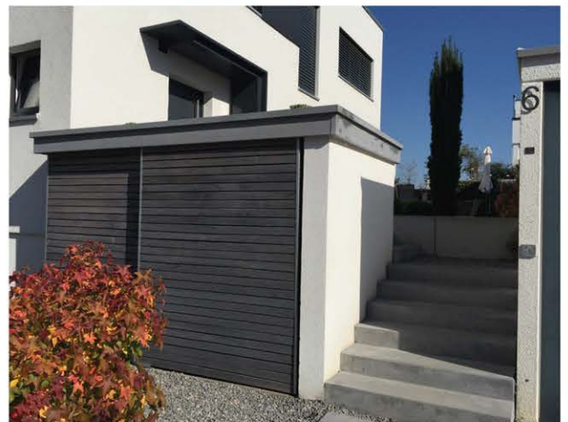
Einhausung am Treppenaufgang
