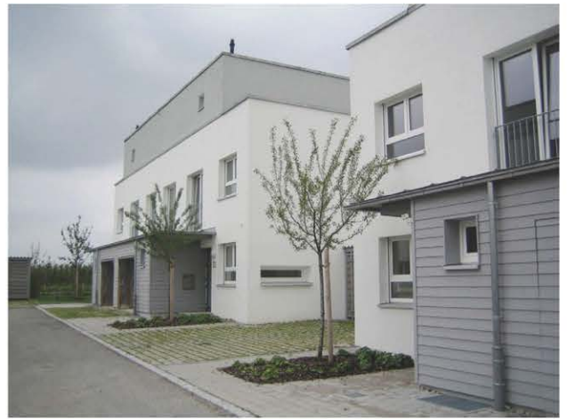
Garage im Haus
