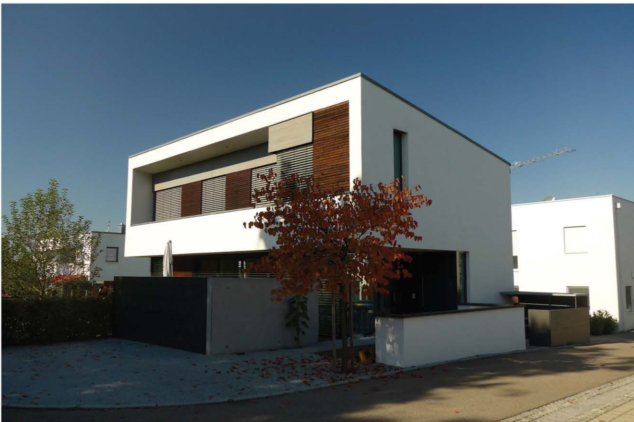
Gebäude mit Pultdach
