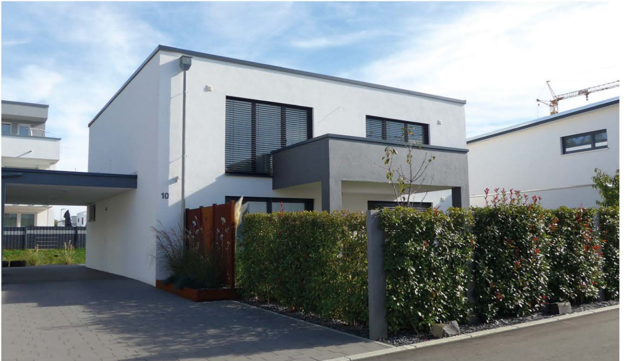
Gebäude mit Pultdach und Garage
