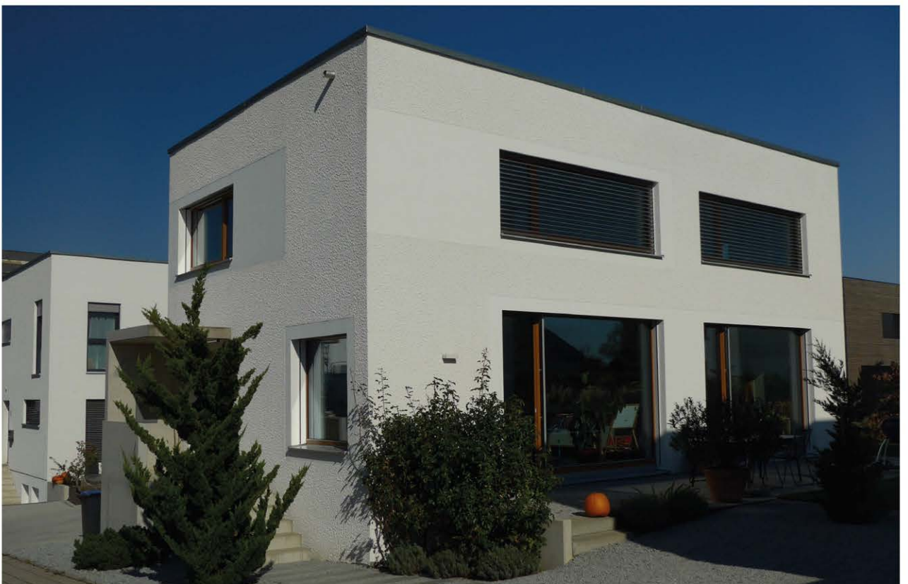
Gebäude mit Putzfassade und Flachdach
