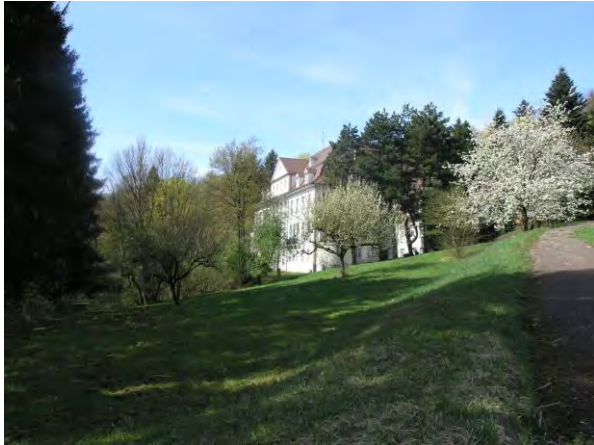
Bild 4: Blick über bestehende Grünflächen im Zentrum des Plangebiets nach Westen zum Thaeder-Haus
