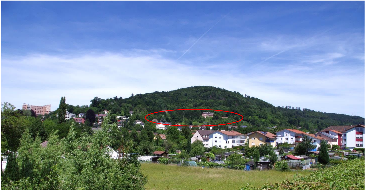
Abbildung 3-1: Foto des Plangebiets von der gegenüber liegenden Talseite.
