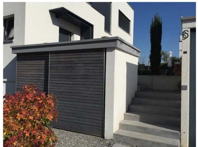
Einhausung am Treppenaufgang
