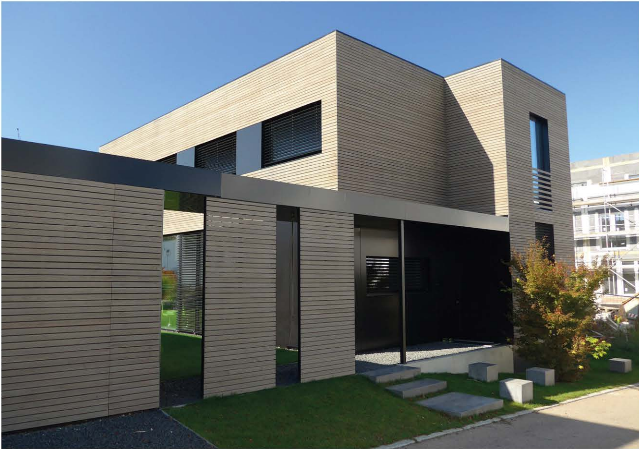
Gebäude mit einheitlicher Fassade
