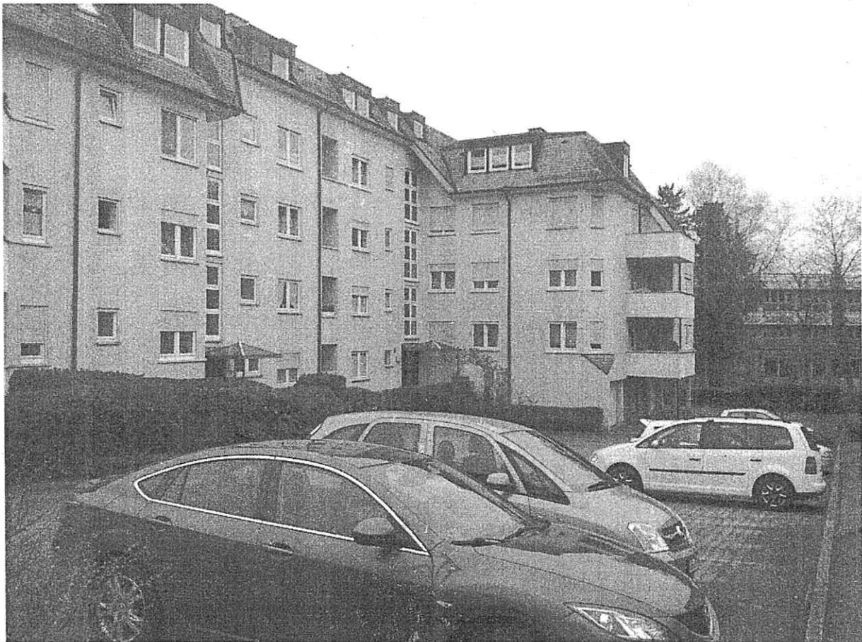
Das Objekt Feuerwehrstraße 25/27 vor der Sanierung.
