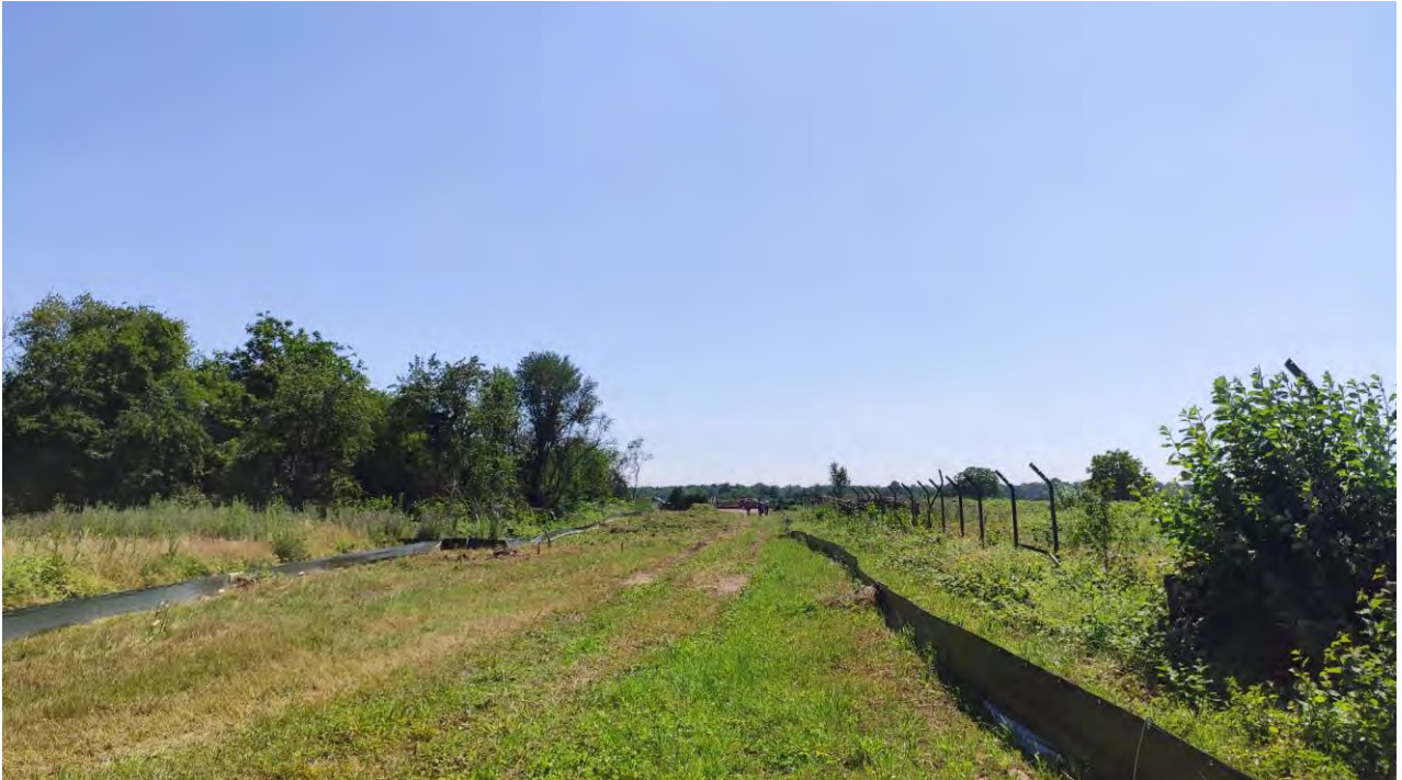
Abbildung 3.2: Blick in Richtung Norden im Bereich der geplanten Baustraße
