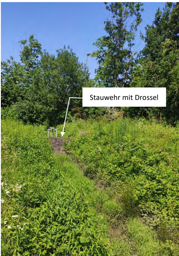
Abbildung 3.3: bestehender Ostgraben (Retentionsgraben) im Bereich des BG Schneidfeld
