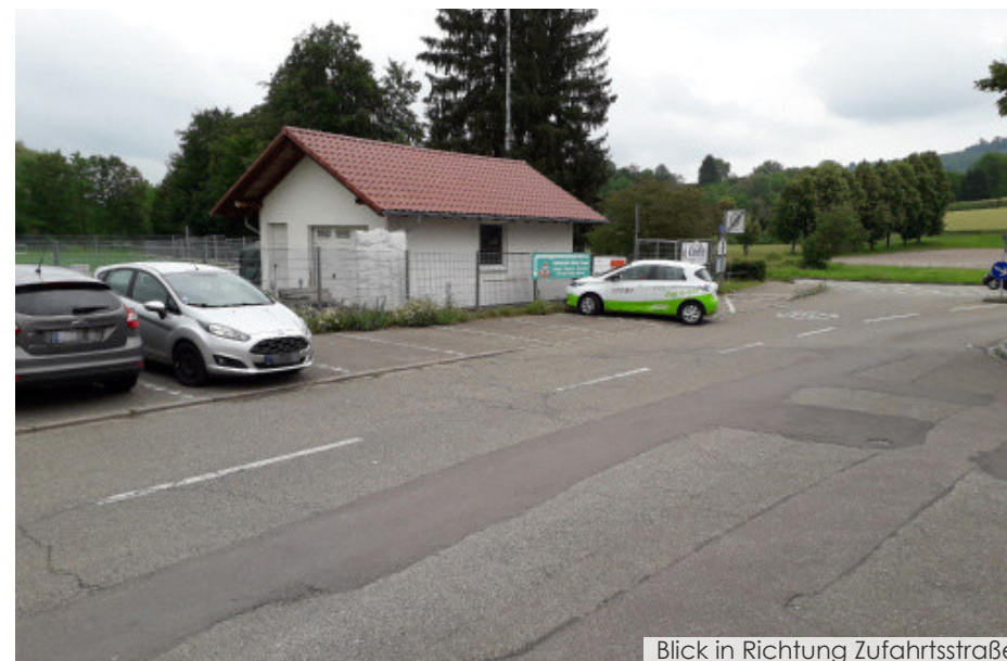
Blick in Richtung Zufahrtsstraße
