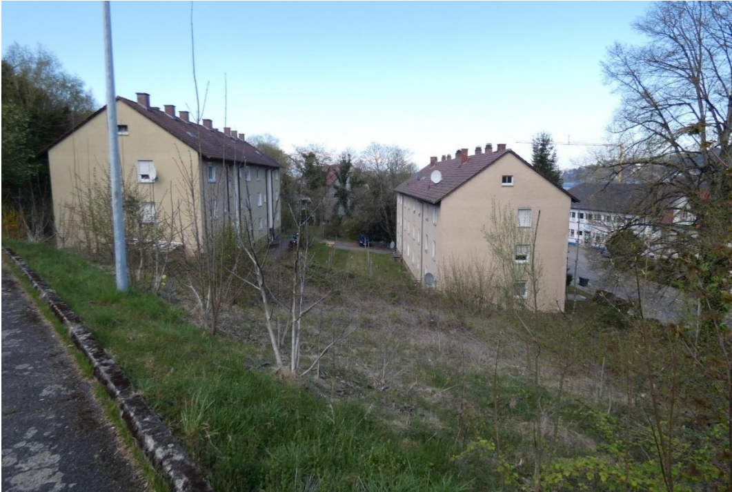
Foto 1 Gestrüppreicher westlicher Böschungsbereich
