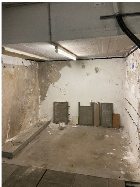
Abbildung 5: Betonwanne in weiß oben im Bild aus Sicht des UG
