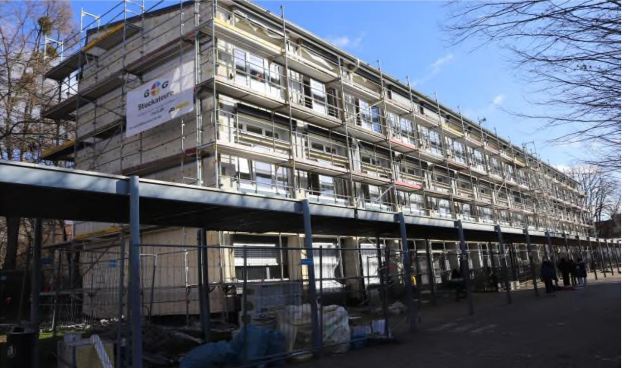
**Bild 2:** 18.11.2022 - gedämmte Fassade, noch nicht verputzt
