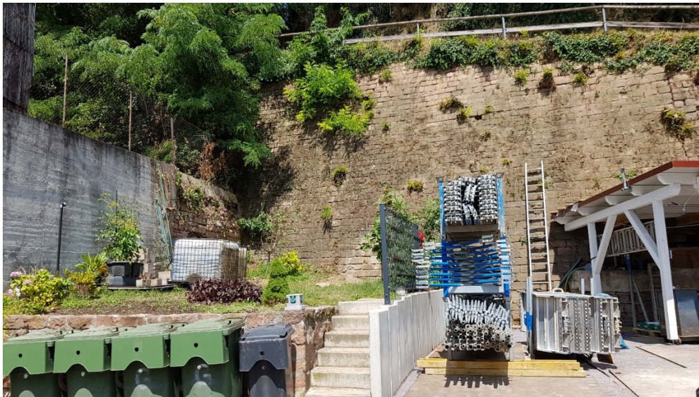
Bestandsaufnahme vor Sanierungsbeginn.
