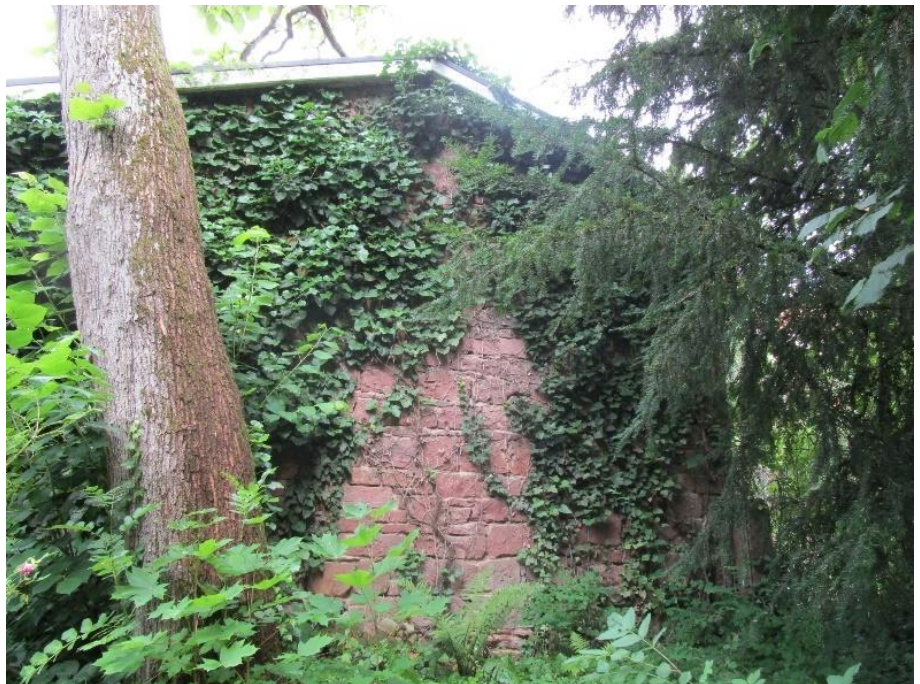
Foto 7: Nebengebäude mit Efeubewuchs
