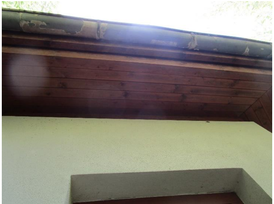
Foto 6: Dachvorsprung am Badegebäude (mit Nische)
