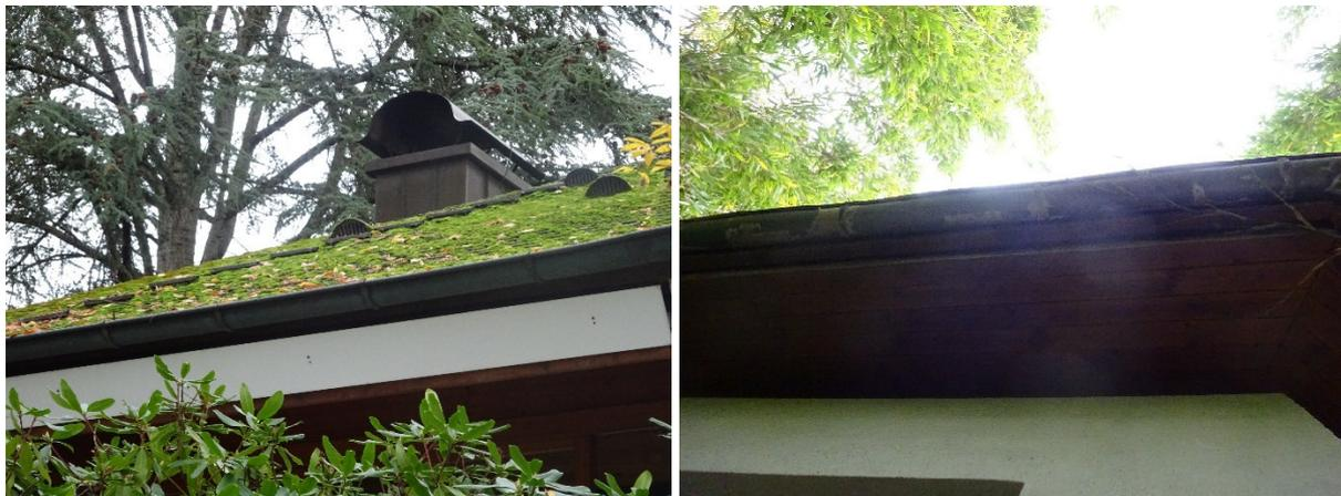
**Abb. 7: Blech an Dachvorsprung (links) und Spalten in Dachvorsprung zwischen Balken (rechts)**
