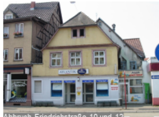
Abbruch Friedrichstraße 10 und 12
