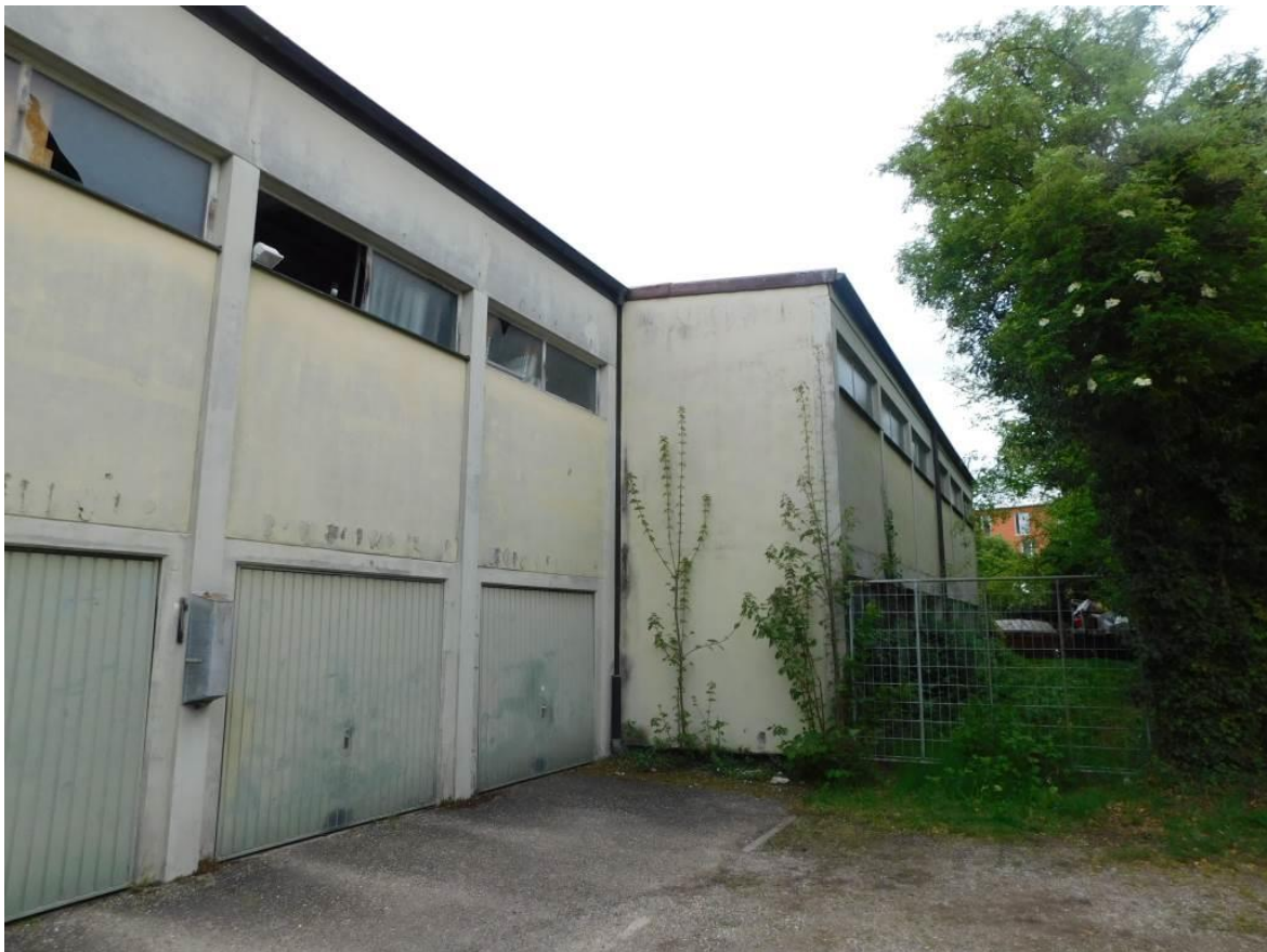
Abbildung 10 Lagerhalle, ohne Quartiernachweis
