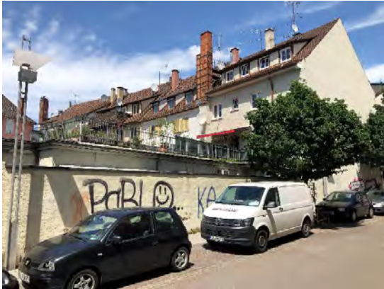
Räumliche Mängel Hofbereich Roßgasse
