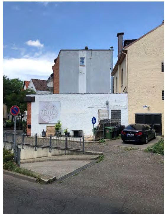
Gestaltungsmängel Fassade, Garagenzufahrt Roßplatz
