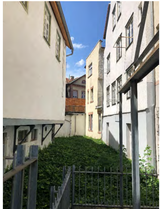
Räumliche Mängel Flächen ehemaliger Gewerbegraben am Roßplatz
