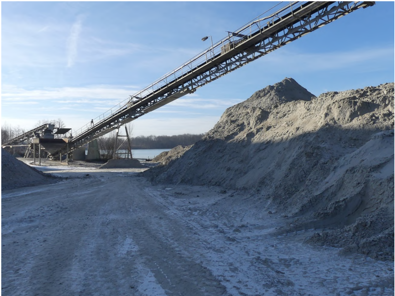
Abbildung 10: Blick von NO auf die geplante Montagefläche (aktuell = Sandlager + Betriebsstraße)
