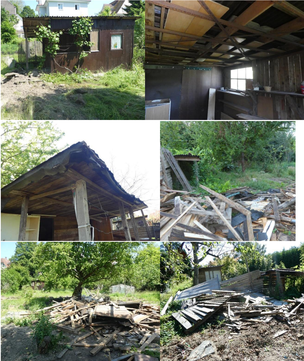
Abbildung 29: Gartenhütten im Plangebiet als potenzielle Zwischenquartiere. (teils bereits abgebrochen) Quelle: Kunz GaLaPlan 2023.
